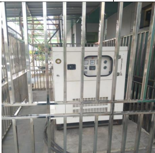
Biodiesel 460 KVA
