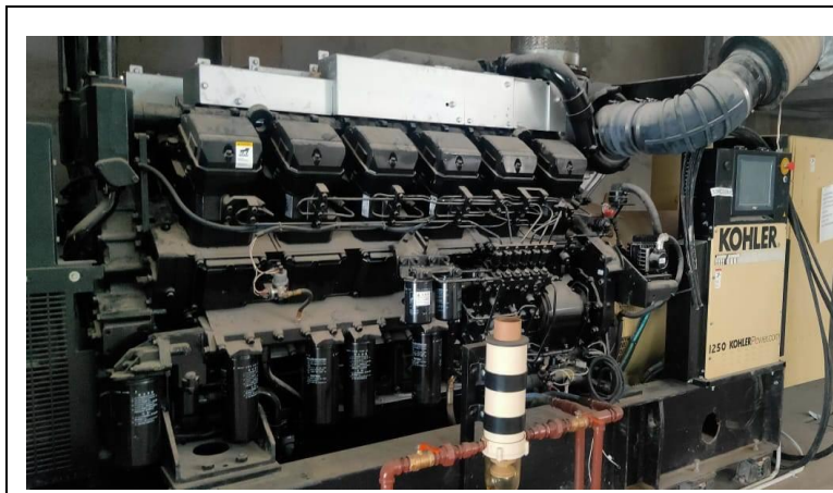
Biodiesel 1250 KVA
