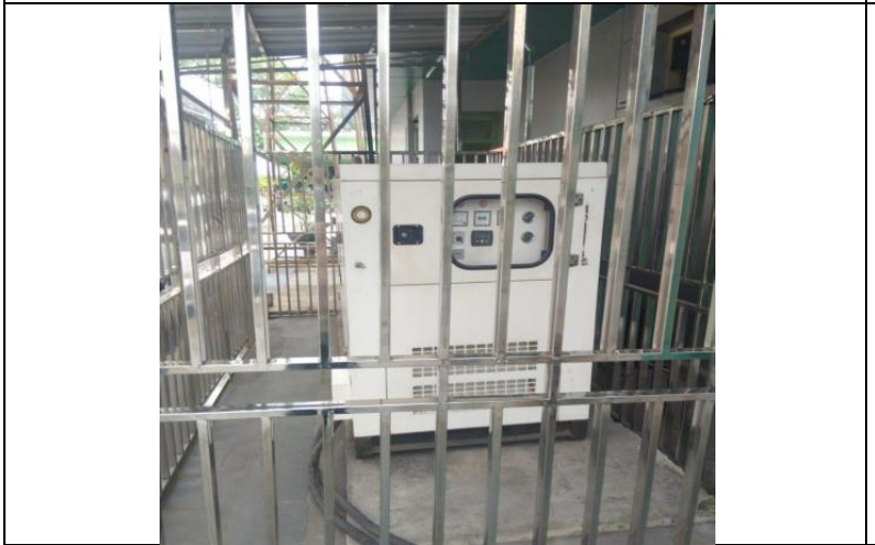
Biodiesel 460KVA
